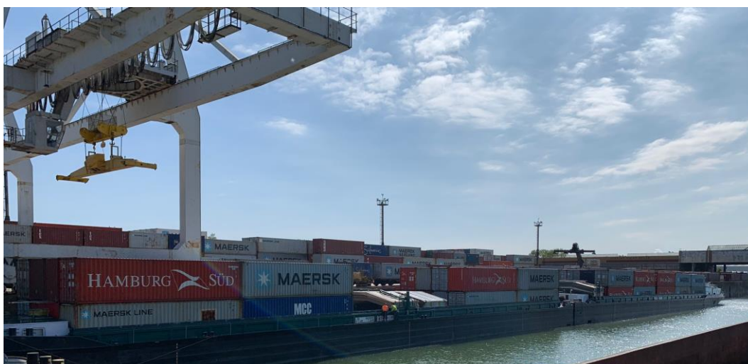
Obr. 3 Nábrežná hrana kontajnerového terminálu v bazéne Pálenisko
