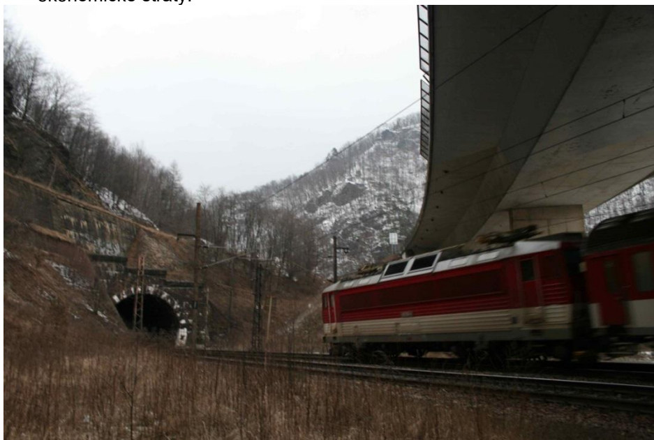
Obr. 1. Tunel Strečno I – jeden z najvýznamnejších tunelov na trati Žilina – Košice (foto: Ing. Kubíčková)
